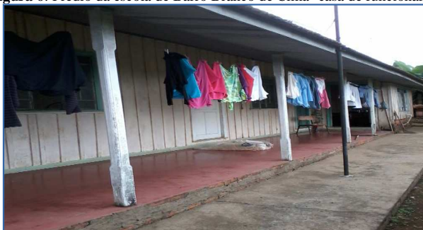
Figura 6: Prédio da escola de Barro Branco de Cima- casa de funcionária do posto de saúde. Rebouças-PR.
