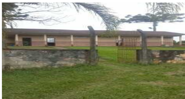
Figura 25: Escola de Rio Bonito – Rebouça - PR
