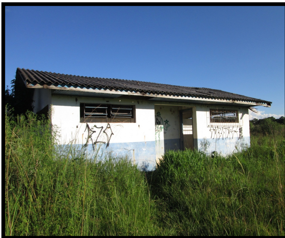
Figura 3 Instalações Sanitárias e Vestiário.
