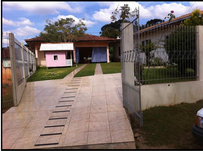
Figura 05: Rampa de acesso principal
