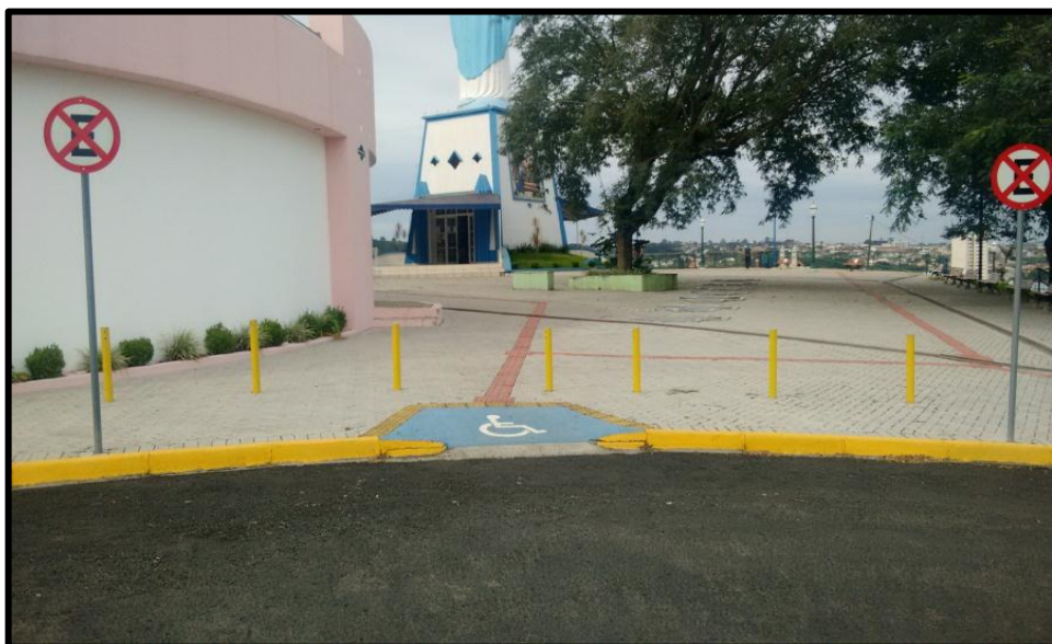
Imagem 9: Rampa de acesso sinalizada na entrada da Imagem Fonte: Acervo do autor, 2016.
