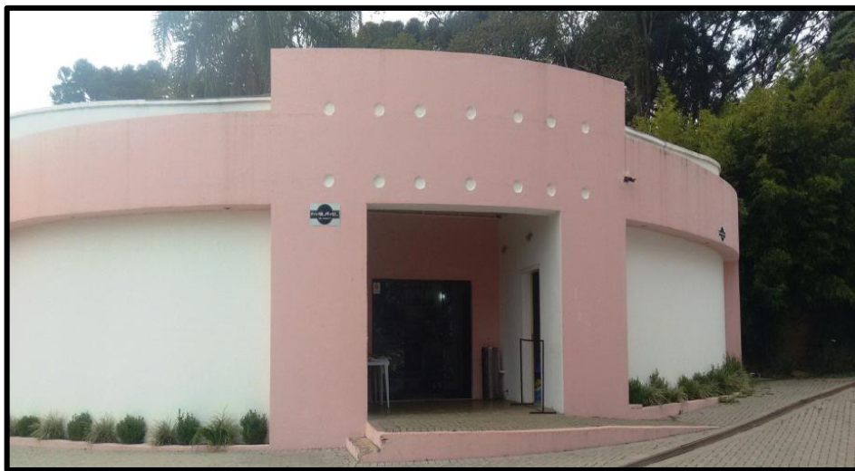
Imagem 7: Rampa de acesso á loja e sanitários. Fonte: Acervo do autor, 2016.
