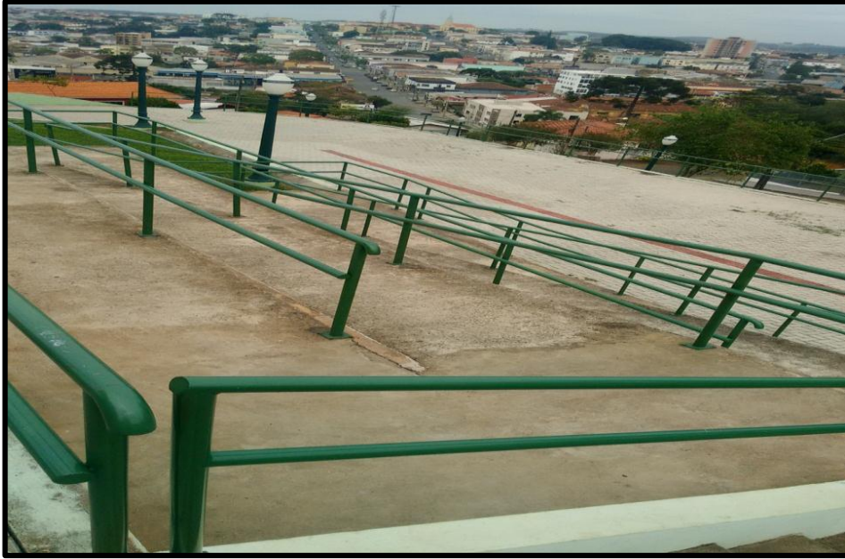
Imagem 8: Rampa de acesso ao estacionamento Fonte: Acervo do autor, 2016.
