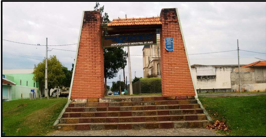
Imagem 21: Portal, entrada principal. Fonte: Acervo do autor, 2016.
