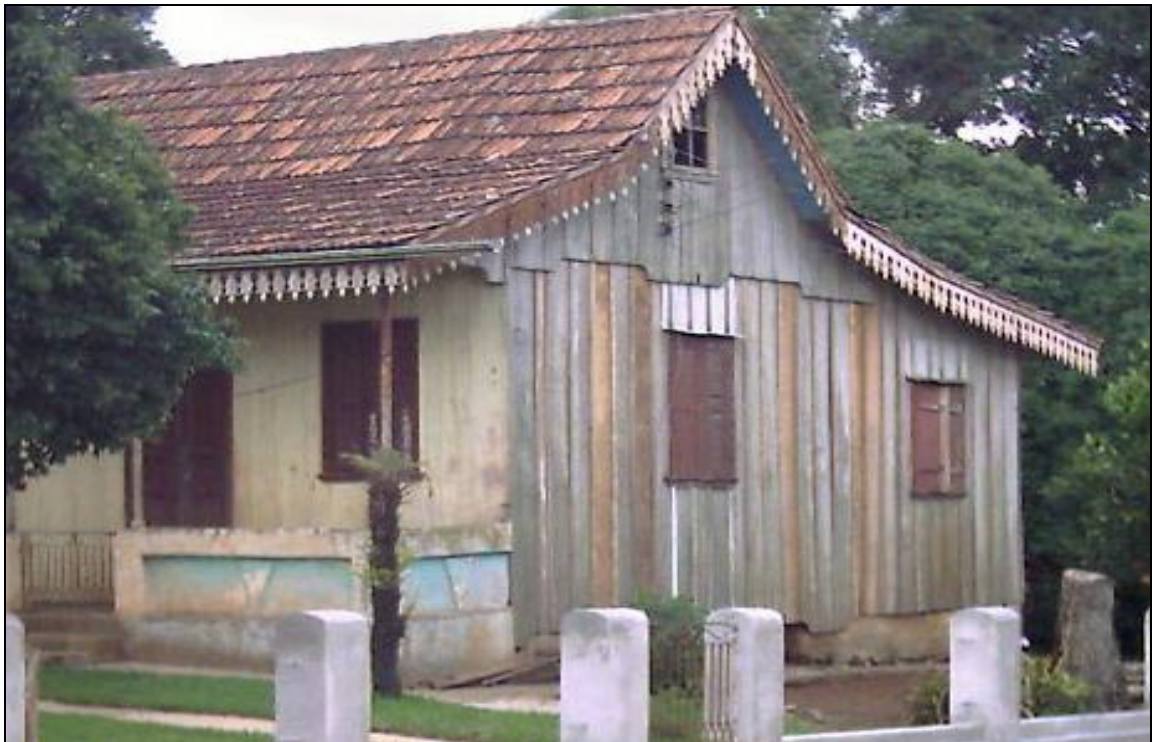
Foto: Residência antes da reforma
