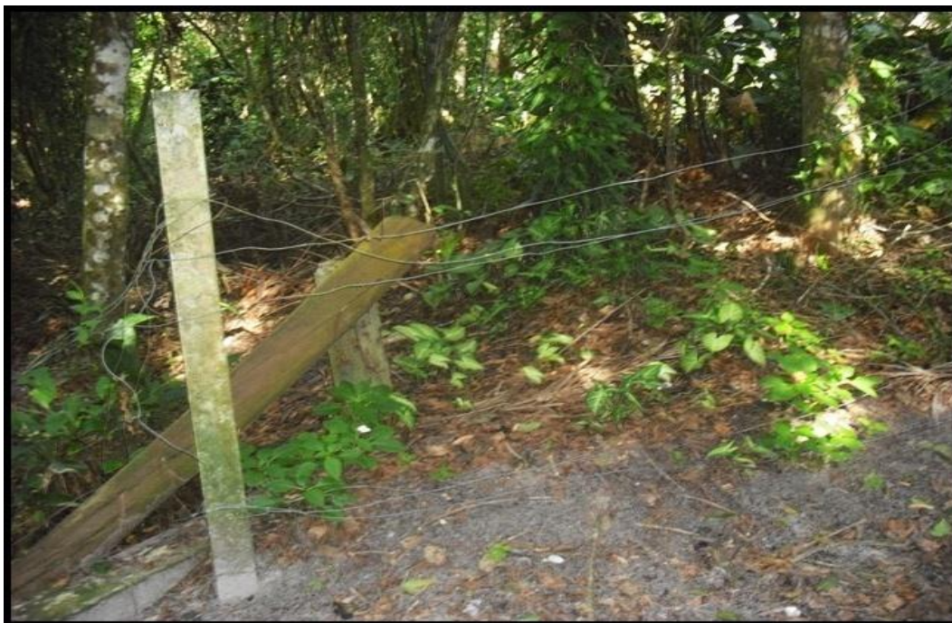
FIGURA 8 – Cercas deterioradas FONTE: DENKEWICZ, Patrícia, 2012
