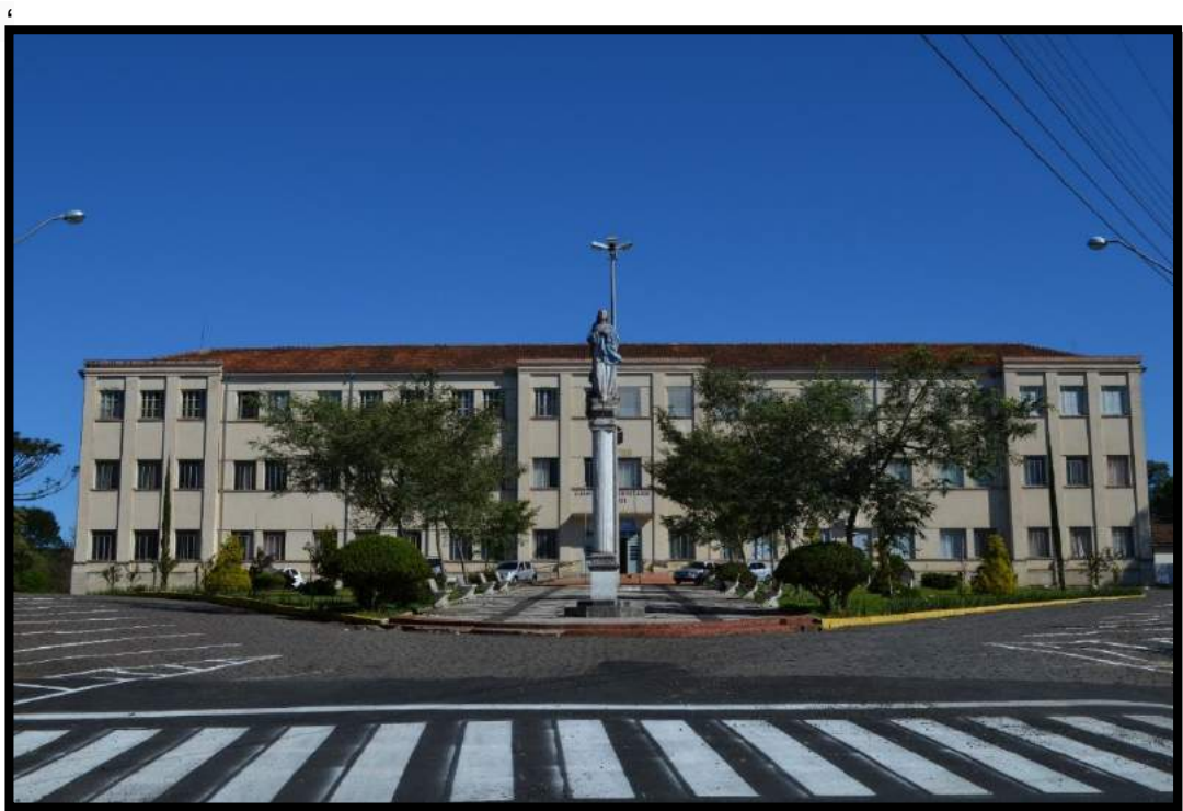
Figura 3 - Fachada da Unicentro, Campus de Irati (PR).
