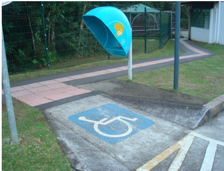
Figura 18 – telefone adaptado e piso tátil. Fonte: fotos da autora deste trabalho.
