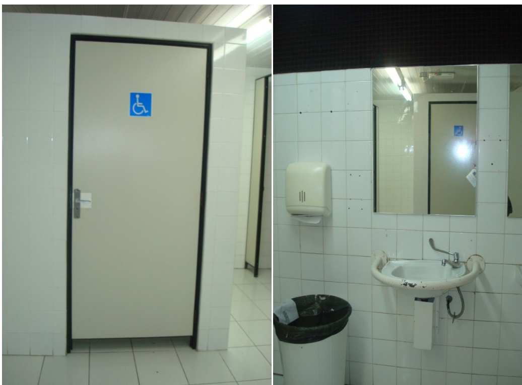
Figura 19 – Porta alargada com 1,20m do sanitário adaptado e lavatório com apenas uma barra. Fonte: fotos da autora deste trabalho.
