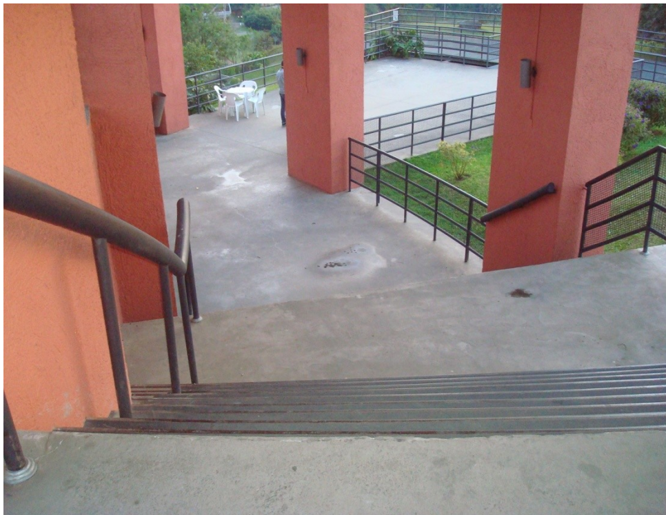
Figura 23 – escadas que impossibilitam um cadeirante ir ao banheiro, bistrô, telefone e loja de souvenir .
