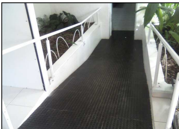
Figura 10 – Rampa com piso antiderrapante Fonte: a autora.
