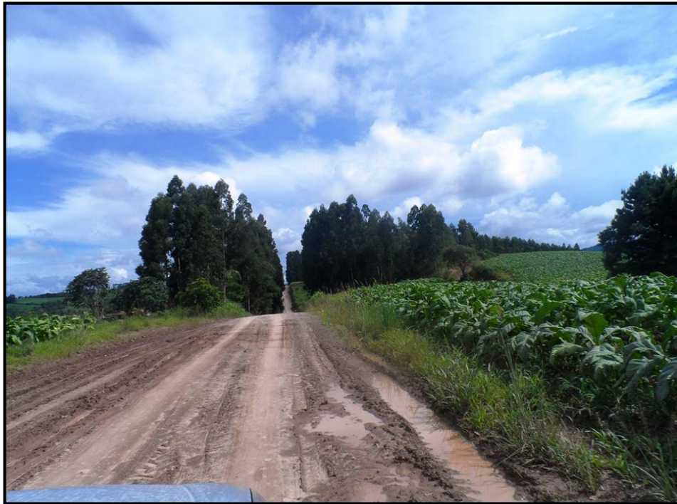
IMAGEM 16 - PARTE DA ESTRADA DE ACESSO A COMUNIDADE
