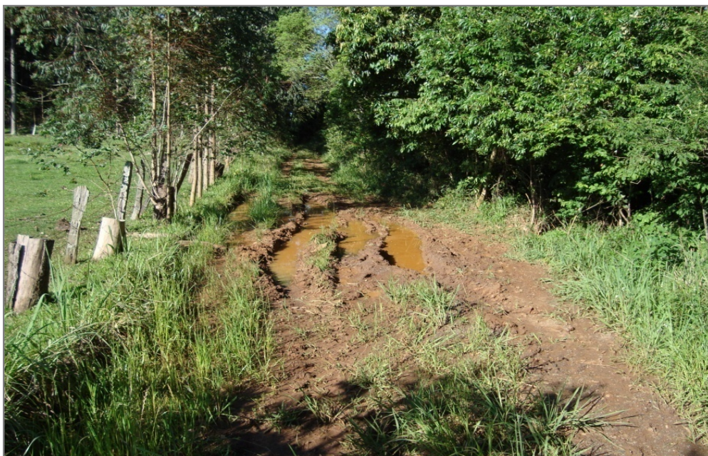
Figura 20 ponto com lama devido a passagem de veículosautomotores localizado entre os pontos 6 e 8 da figura 6, considerado - área de risco
