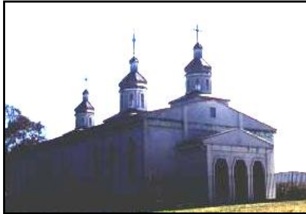
IMAGEM 7: Igreja de São Basílio Magno na localidade de Bracatinga. FONTE: Prefeitura Municipal de Prudentópolis (2012, p. 85).
