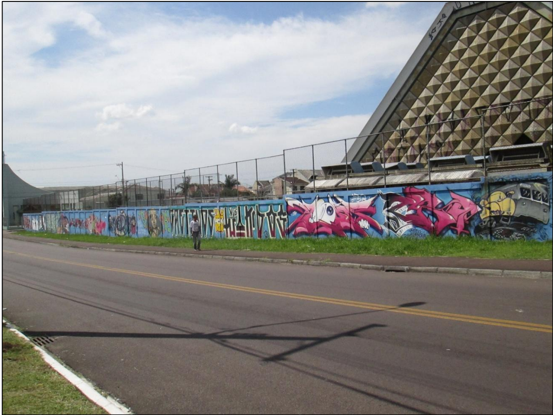
IMAGEM 13: Muro do CAIC Bairro Novo.
