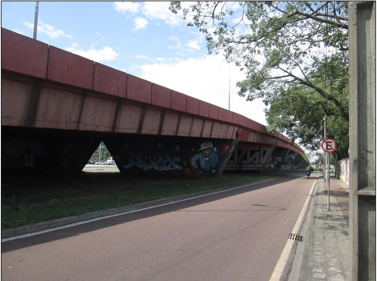
IMAGEM 17: Pilastras do viaduto.
