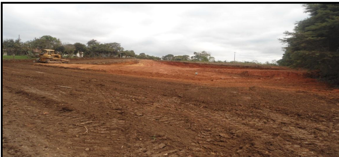
Imagem 3 - Terraplanagem do Local para construção da Praça Memorial Colônia Cecília
