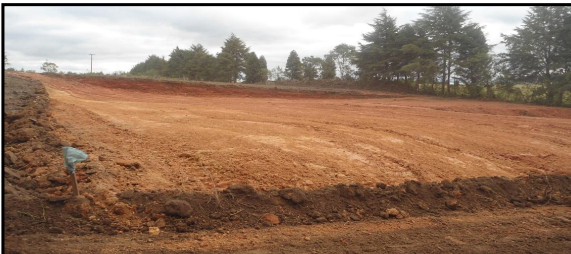
Imagem 4 - Terraplanagem do Local para construção da Praça Memorial Colônia Cecília
