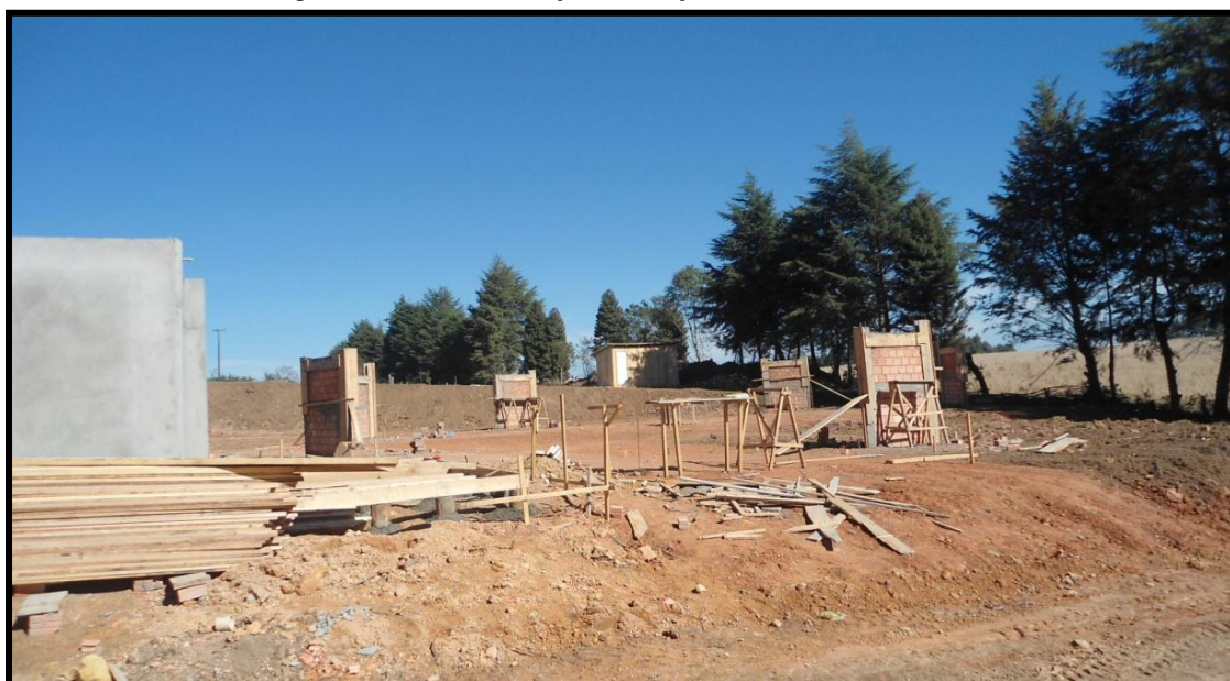
Imagem 6 - Início construção da Praça Memorial Colônia Cecília
