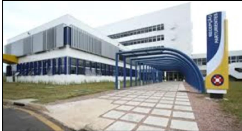
Figura 01: Hospital Universitário Regional dos Campos Gerais. Fonte: Portal Ponta Grossa (2014).
