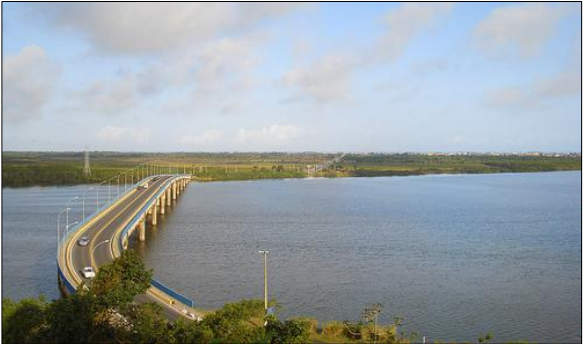
Figura 04 – Ponte Prefeito Laércio Ribeiro. Fonte: FAUSTINO, 2013.
