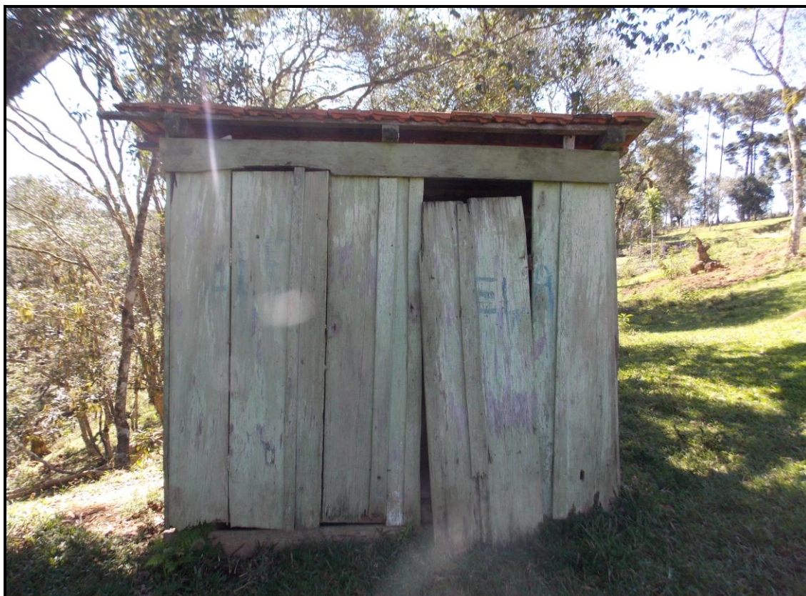
FIGURA 8 – Sanitários Fonte: acervo pessoal
