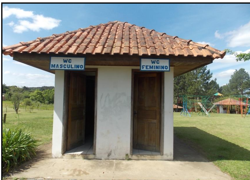
FIGURA 46 – Sanitários do parque (1) Fonte: acervo pessoal
