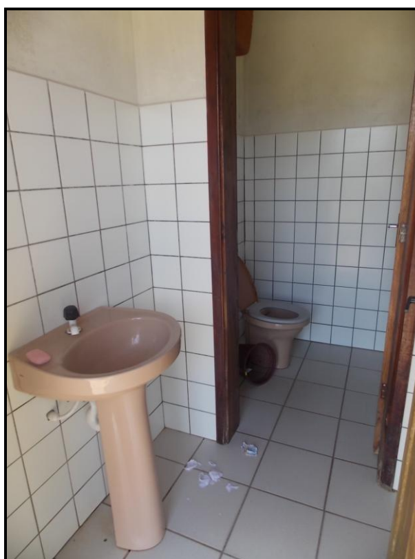
FIGURA 47 – Sanitários do parque (2) Fonte: acervo pessoal
