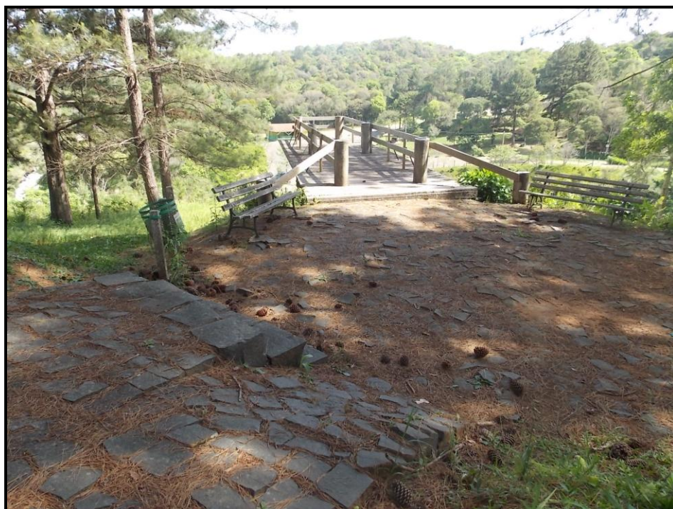
FIGURA 36 – Acesso no mirante Fonte: acervo pessoal
