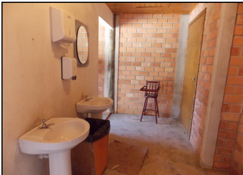
FIGURA 20 – Sanitários (2) Fonte: acervo pessoal
