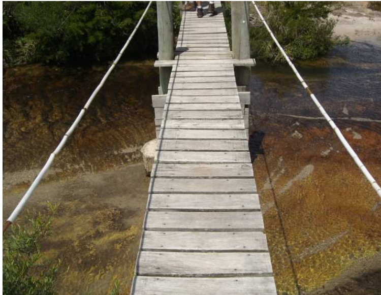
Fig. 24: Ponte de Madeira
