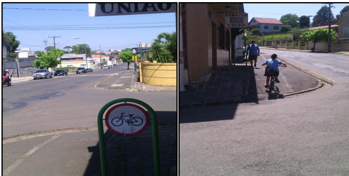
Figura 5 - Trecho 01 Calçada junto à ciclovia.
