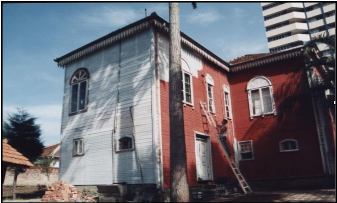
Figura 12: Reforma da Casa da Cultura, em 2001. Fonte: Repositório digital da Casa da Cultura. 16
