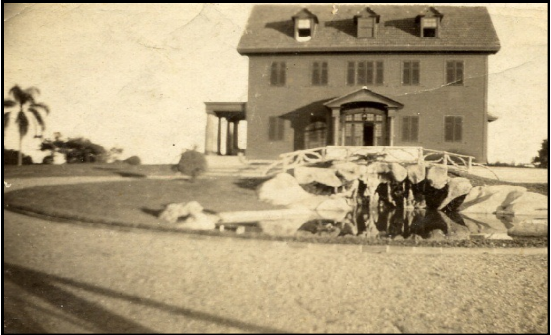
Figura 05: Casa Sede da Fazenda Florestal, Janeiro de 1938. Fonte: Repositório digital da Casa da Cultura. 8
