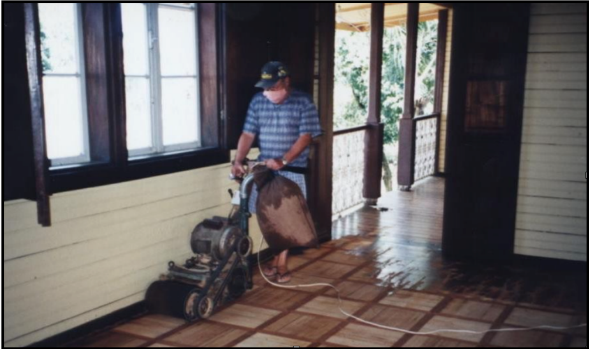
Figura 13: Reforma da Casa da Cultura, em 2001. Fonte: Repositório digital da Casa da Cultura. 17
